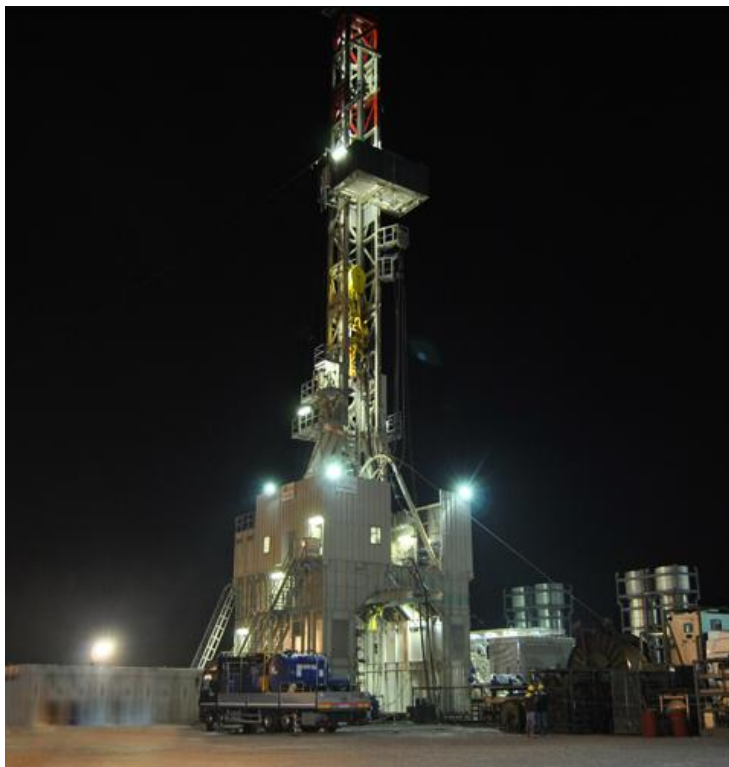
Impianto di perforazione relativo al pozzo Volturino 1.
